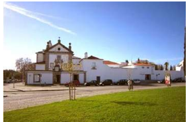
Fig.16 · Évora. Convento de Nossa Senhora dos Remédios. Vista do conjunto monástico.
