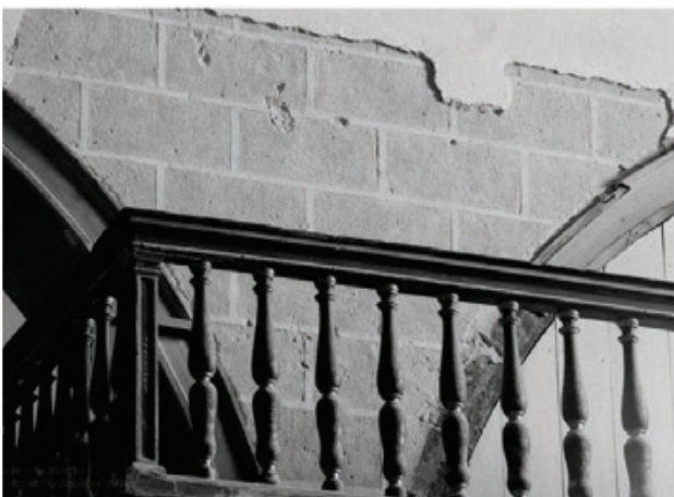
Fig 02. Vestígios de revestimento parietal a imitar a estereotomia da pedra com juntas salientes na nave da Sé de Faro. Fonte: Sítio do SIPA (Sistema de Informação para o Património Arquitetónico: Ficha de inventário da Sé de Faro)
