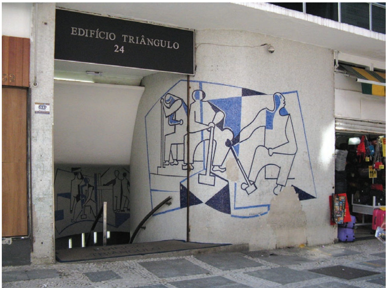
Fig 05. Emiliano Di Cavalcanti, sem título , c. 1955. Edifício Triângulo (centro), arq.: O. Niemeyer. Foto da autora em 09/03/12.
