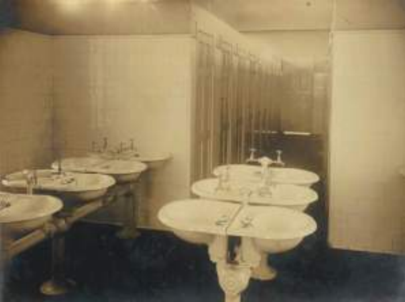
Fig. 22. Instalações sanitárias para pacientes, em 1926. Fonte: Álbum fotográfico da inauguração do Leprosário São Roque. Acervo: Hospital de Dermatologia Sanitária do Paraná.
