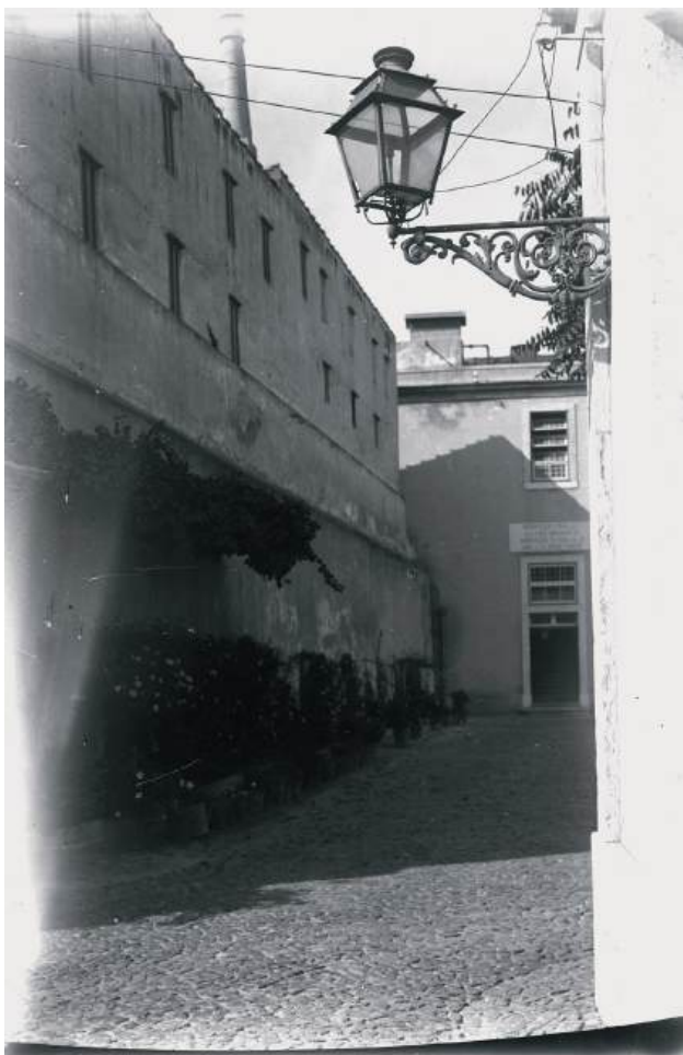
Fig. 07. Eduardo Portugal, Hospital do Desterro, 1944. Arquivo Fotográfico de Lisboa, PT-AMLSB-CMLSB AH-PCSP-004-EDP-000687
