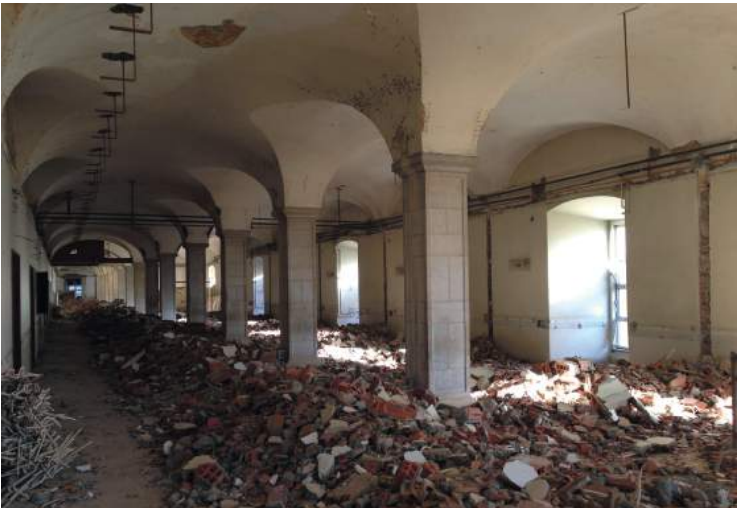
Fig. 12. Pedro Domingos Arquitetos. Projeto de intervenção no antigo Mosteiro/Hospital do Desterro, Lisboa, 2013-2017. Demolições no dormitório dos monges.
