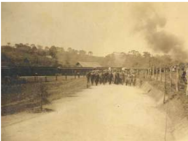
Fig. 04. Inauguração do Leprosário São Roque - Chegada dos convidados, em 20 de outubro de 1926. Álbum fotográfico da inauguração do Leprosário São Roque. Acervo: Hospital de Dermatologia Sanitária do Paraná.
