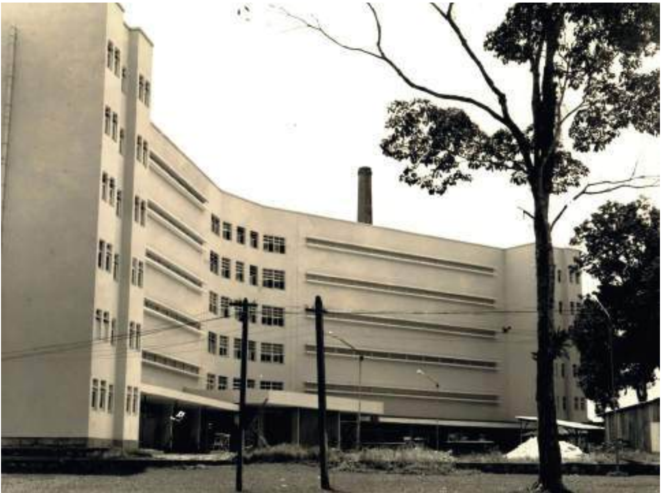
Fig. 02. Fachada oeste do Sanatório Barros Barreto (1938-1959), marcada pelo uso de janelas em vidro e alumínio (Acervo fotográfico da Biblioteca do HUJBB, s/d).
