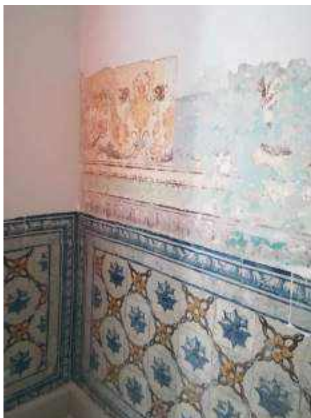
Fig. 07. Pintura mural em edifício da Rua da Padaria, 2018. ERA-Arqueologia S.A.
