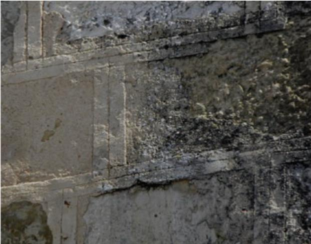
**Fig 06.** Vestígios de revestimento parietal a imitar a estereotomia da pedra com juntas salientes no exterior da torre da matriz de São Clemente de Loulé. (foto do autor)
