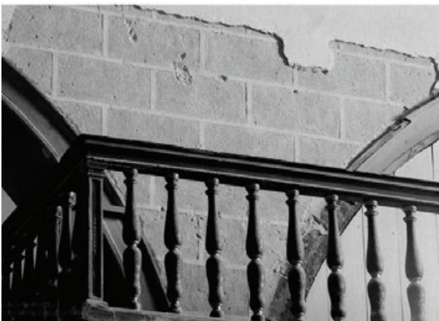
**Fig 02.** Vestígios de revestimento parietal a imitar a estereotomia da pedra com juntas salientes na nave da Sé de Faro.
