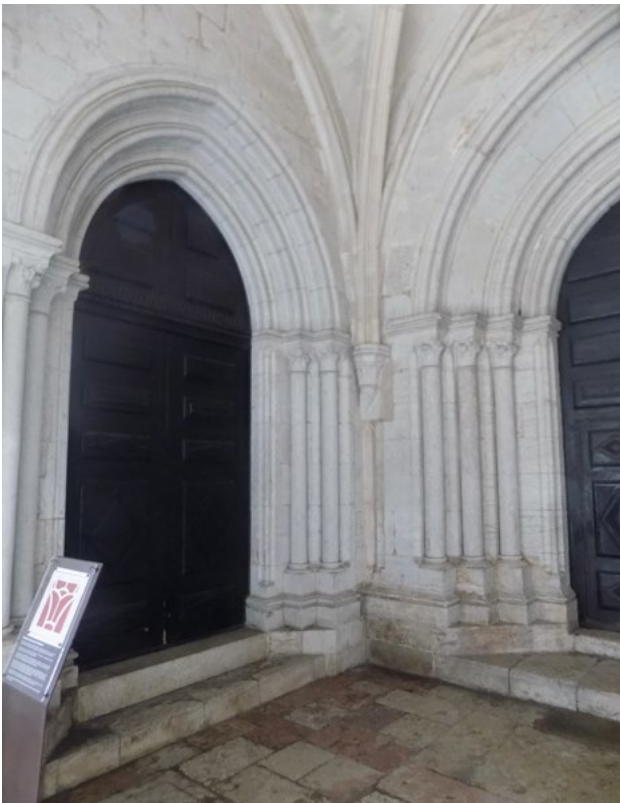
Fig. 04. Igreja de S. Dinis, Odivelas; Portal da capela (de São Luís?), post 1325 (fot. de Giulia Rossi Vairo).
