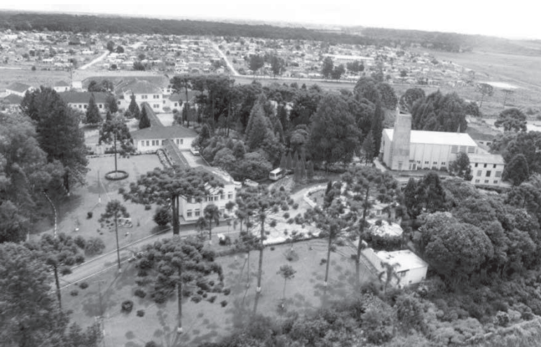
Fig. 27. Vista aérea do conjunto arquitetônico do Hospital de Dermatologia Sanitária do Paraná, antigo Leprosário São Roque, na década de 1990. Acervo: Hospital de Dermatologia Sanitária do Paraná.
