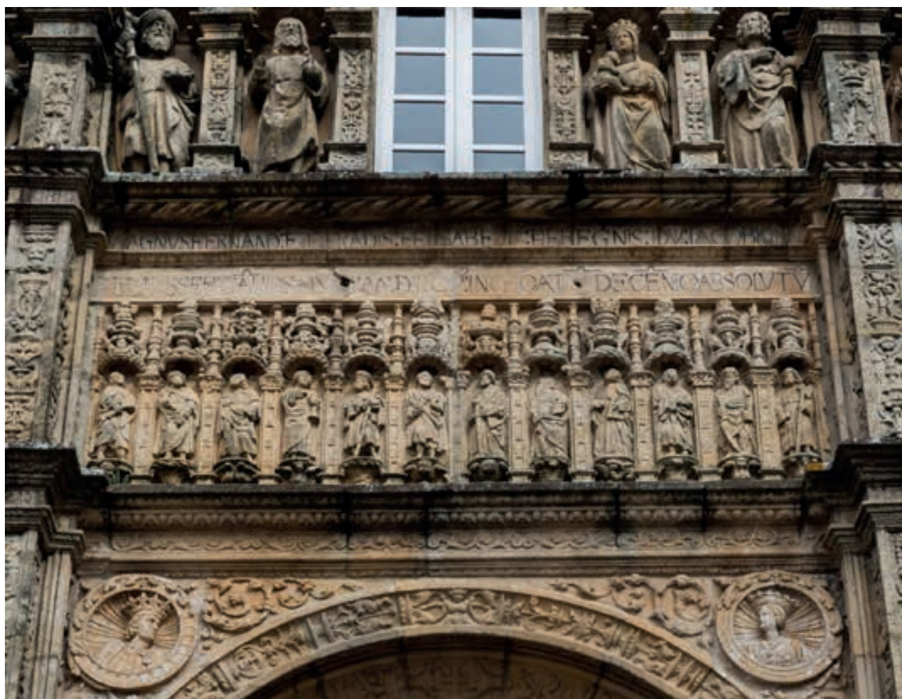
Fig. 04. Detalle de la portada del hospital Real de Santiago de Compostela con inscripción y apostolado. Foto © Wikimedia Commons 30 .
