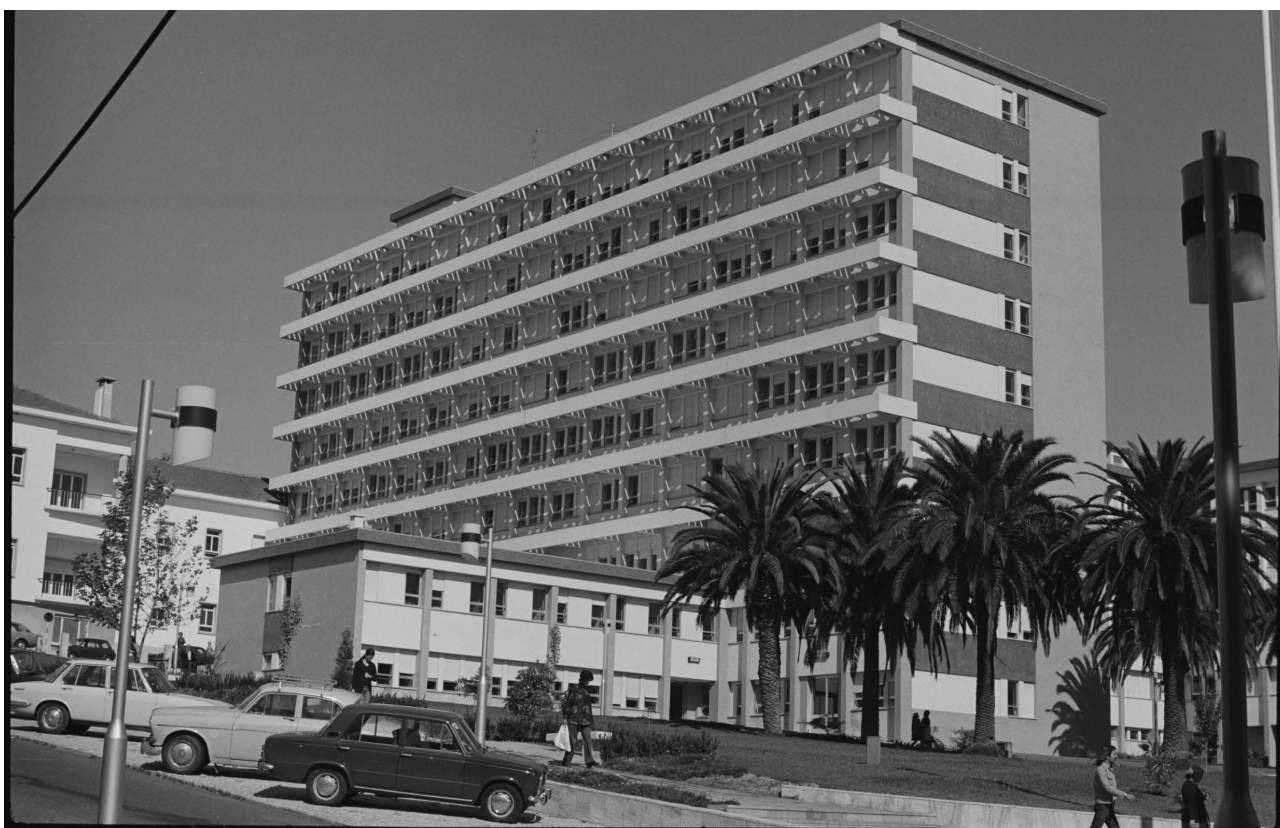
Fig. 02. Hospital do Ultramar: ampliação, arq. Lucínio Cruz. Fotografia de autor desconhecido, s.d. Arquivo Municipal de Lisboa — Fotográfico, cód. ref.º PT/AMLSB/CMLSBAH/PCSP/004/PEL/009/000025.
