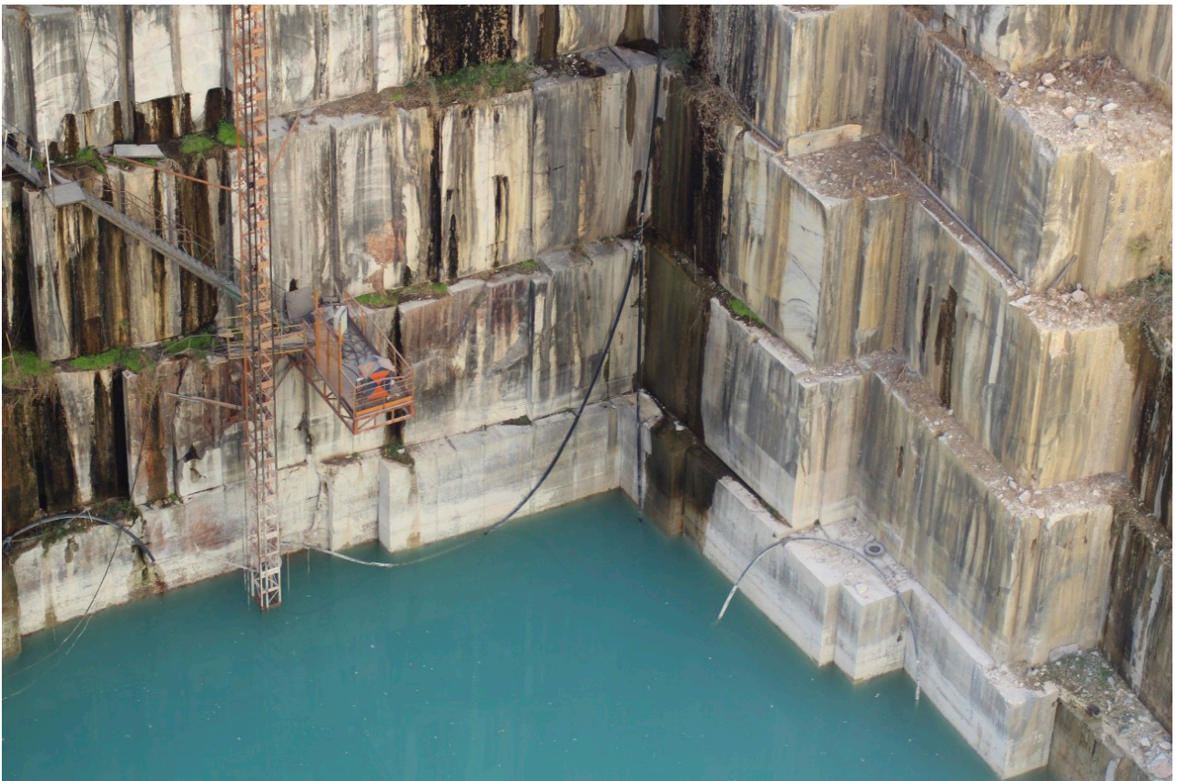
Fig. 02- Vista parcial de pedra, Vila Viçosa. Foto de Mariana Penedo dos Santos, 2017.
