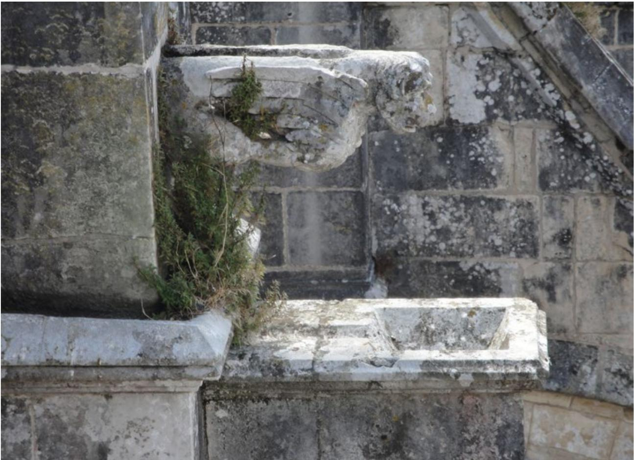
Fig.1 · Mosteiro de Santa Maria da Vitória, solução hidráulica superior inovadora com utilização de taças quadradas.
